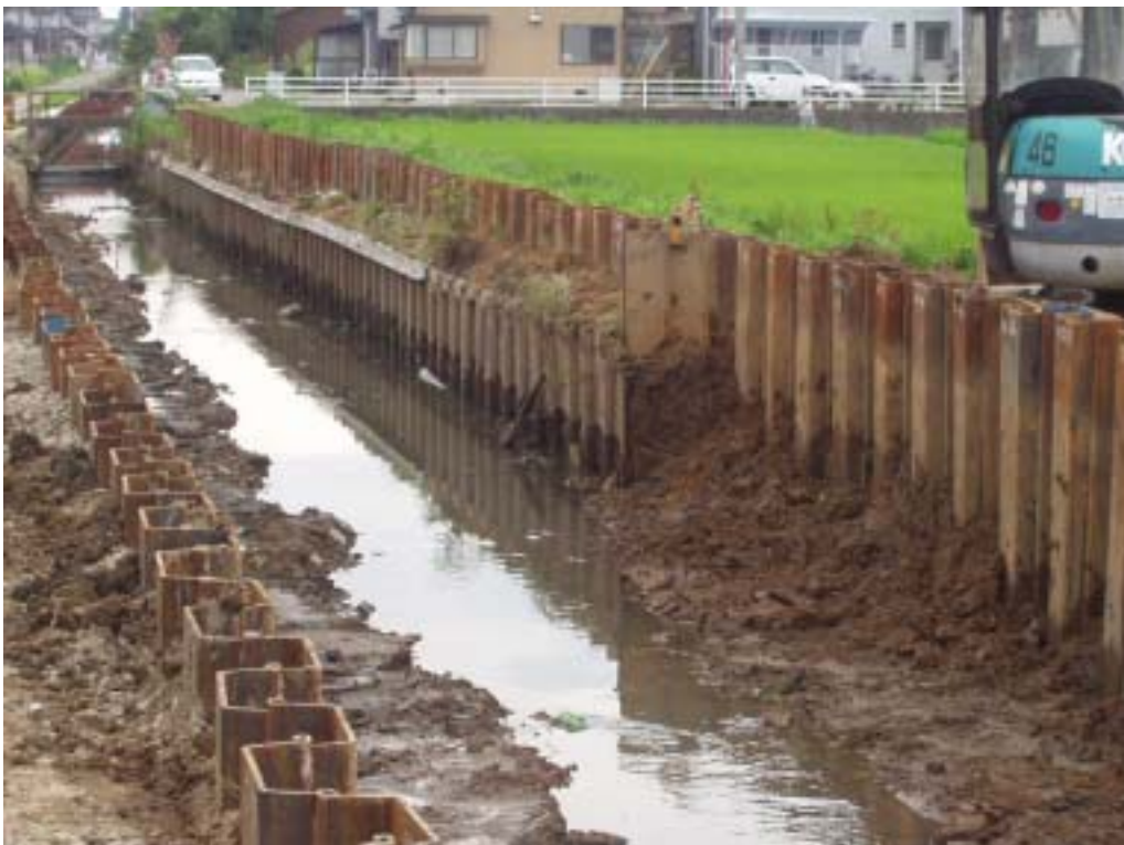
既設水路撤去後(放置中)
