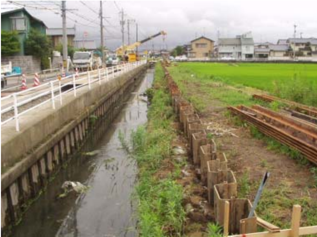
鋼矢板打ち込み中
